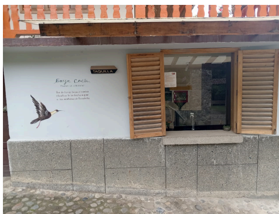
Taquilla con altura adecuada para la atención a la ciudadanía
