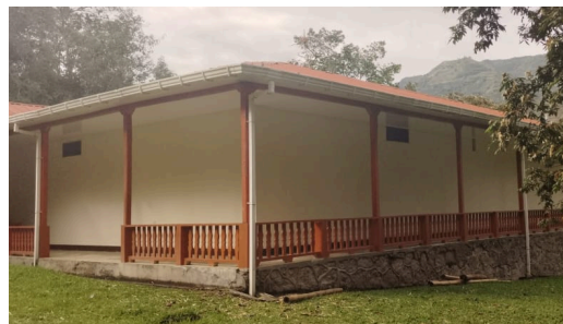
Detalle acabado de paredes
