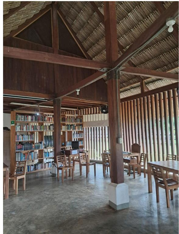
Pared con estructura de madera que permite la visibilidad y entrada de luz
