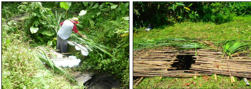
Ilustración 21. Protección directa del horno con bolsas rellenas con arena y cobertura permanente con caña brava. Fuente: LEHPC, 2007
