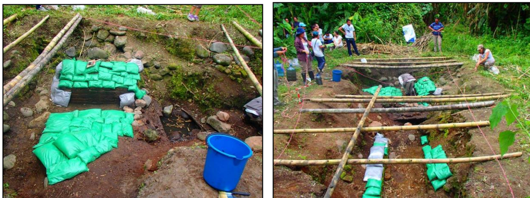
Ilustración 23. Nueva protección con bolsas en polietileno. Fuente: LEHPC, 2010
