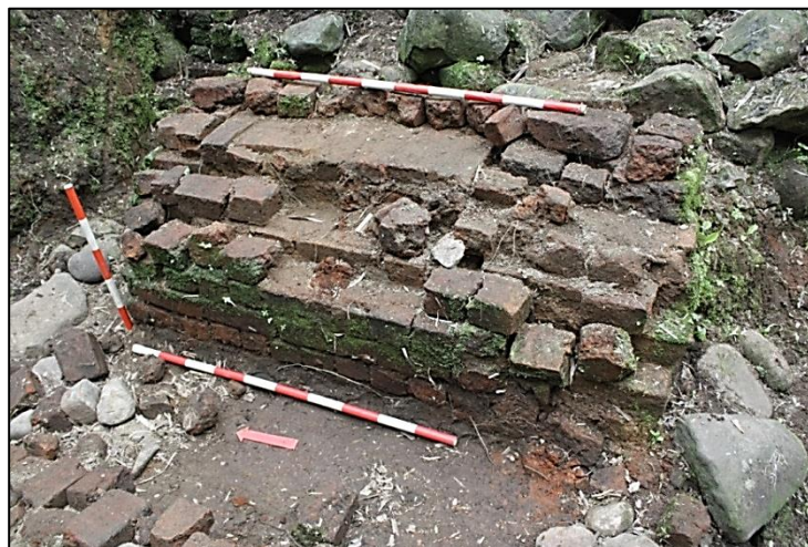
Ilustración 18. El Muro 1 es el más afectado por la pérdida de más del 50% de su volumen desde el 2003, por el factor antrópico.
