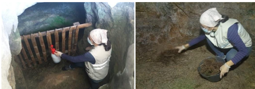
Ilustración 75. Tratamiento de diaclasas, grietas, fracturas y oquedades
