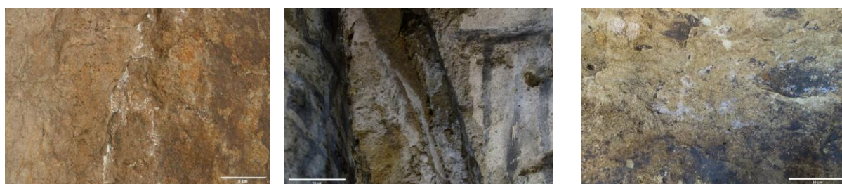
Depósito blanco hipogeo S11
