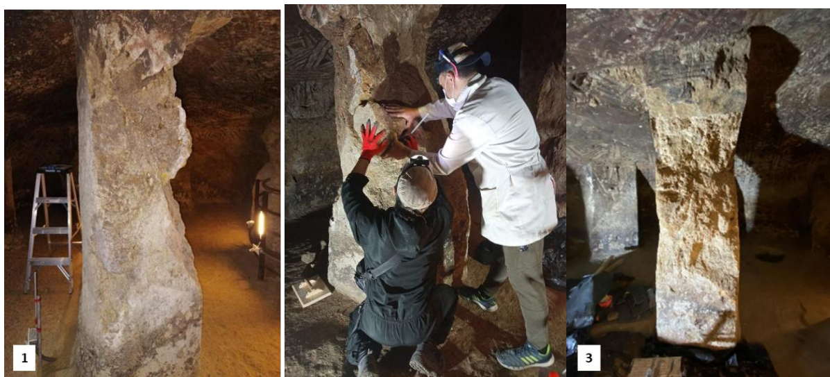
Ilustración 71. Secuencia: Imágenes 1 y 2, Condición inicial de la columna 1 (P1). Imagen 3. Resultado final de la intervención estructural en P1; imagen 4, proceso de intervención.
