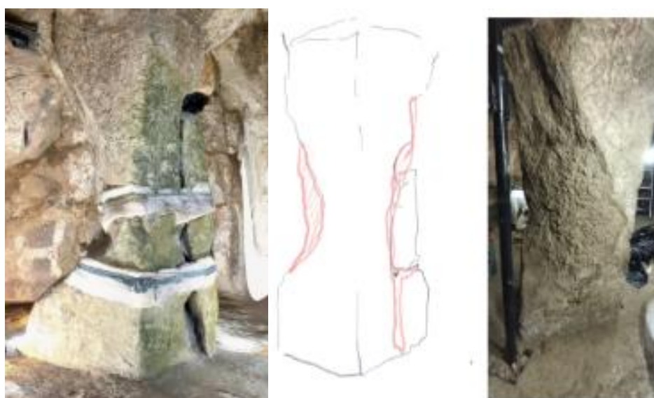
Ilustración 76. Imagen 1 antes de la intervención, 2 en rojo zonas intervenidas y 3. Parte posterior de la columna donde se le la cantidad de mortero estructural aplicado.
