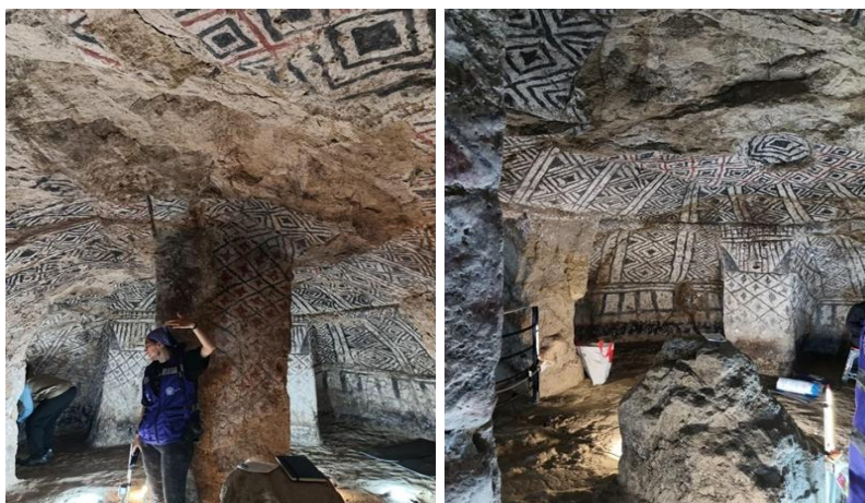
Ilustración 72. Condición inicial a nivel de bóveda.
