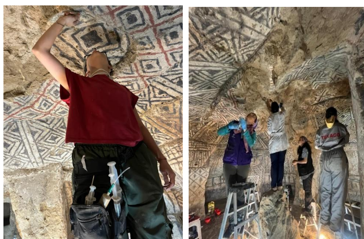
Ilustración 73. Intervenciones de inyección de micromortero a nivel de bóveda.
