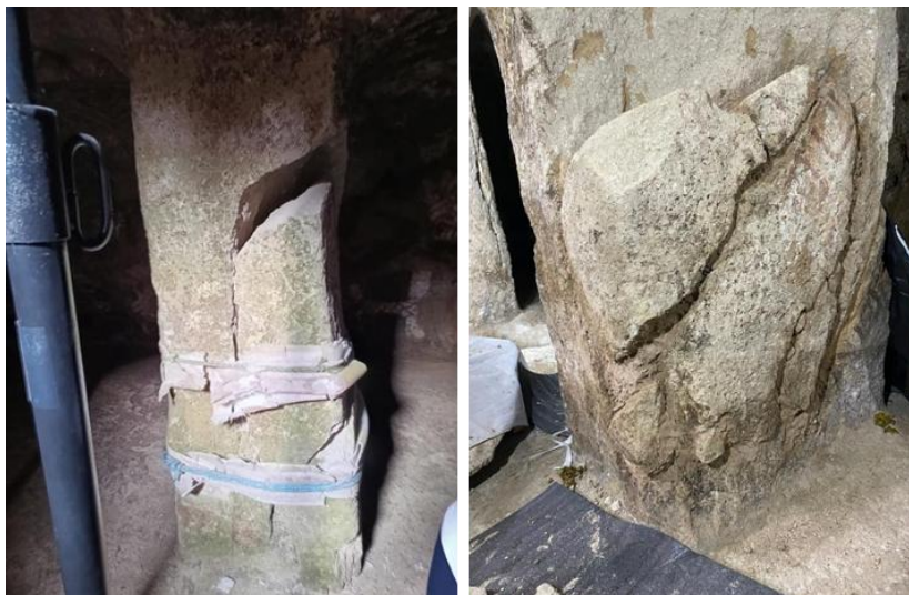
Ilustración 77. Detalle donde se aprecia el fragmento inferior antes y después de unirlo
