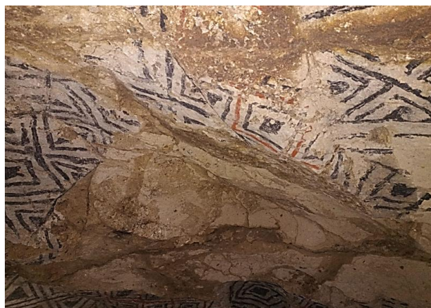
Ilustración 26. Pérdida de pieza en forma de cuña a nivel de bóveda
