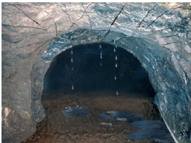
Ilustración 24. Proceso de infiltración del agua a través de las diaclasas.
