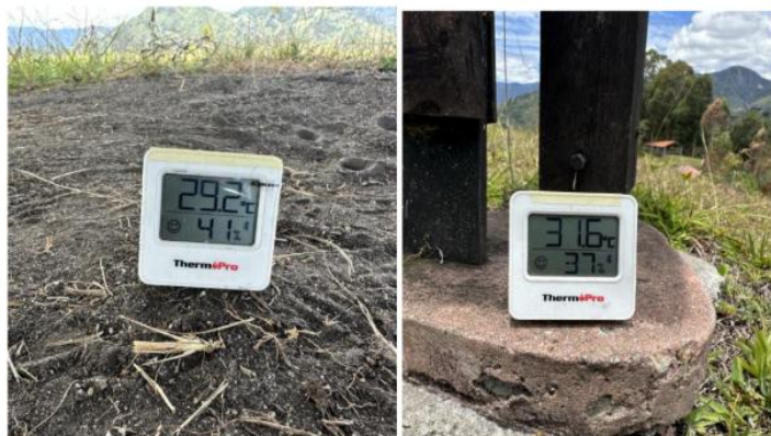
Ilustración 95: Instalación de dataloggers al exterior de los cobertizos. Fuente: Proyecto FIAN 2025-2026
